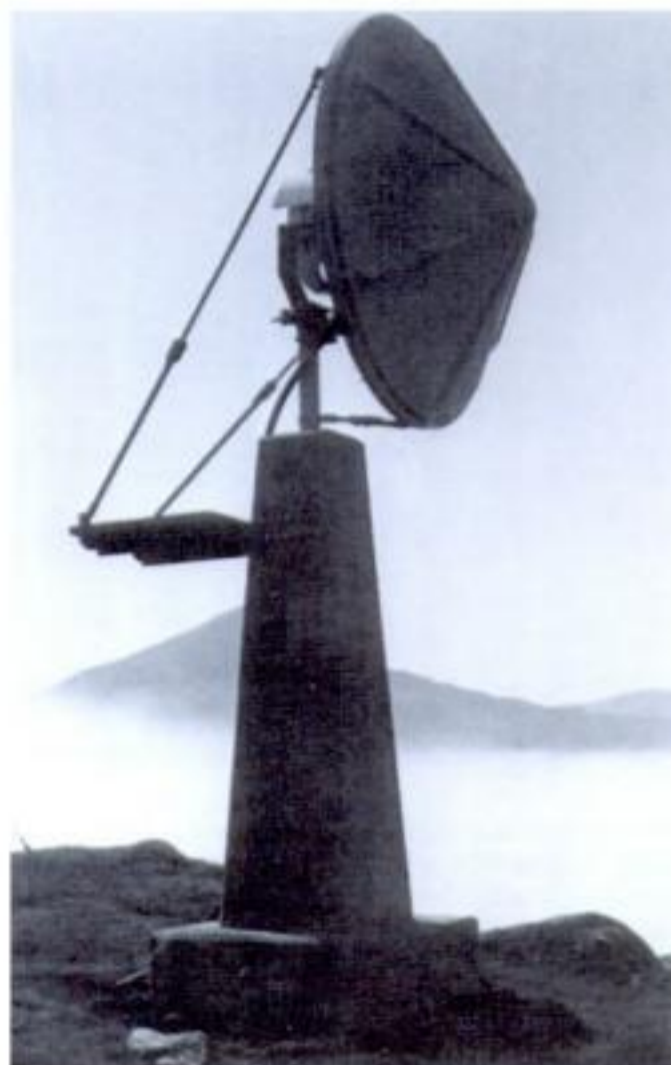
Mikrobylgjuantenna á Hálsi oman fyri Klaksvík. Um hesa antenu og ein spegil á Kalsoynni fáa felagarnir í Kunoyarbygd telefonsamband.
