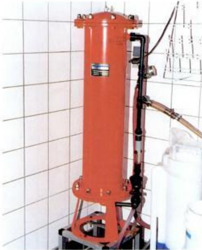
Demineraliseringstól. Demineraliserað vatn verður gjørt í einum elektriskum tóli.
