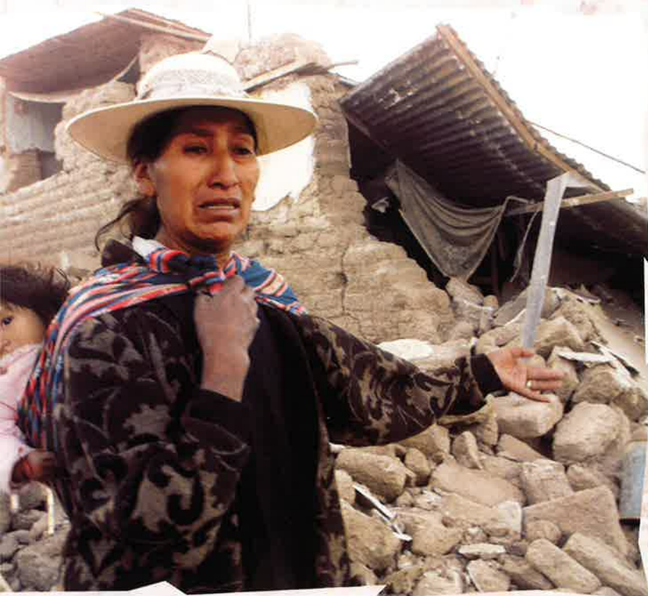
En kvinde fra en by i Perus højland foran ruinerne af sit hus, der blev totalt ødelagt ved et jordskælv i 2001. Kvinden og hendes barn overlevede – men 70 naboer omkom.
