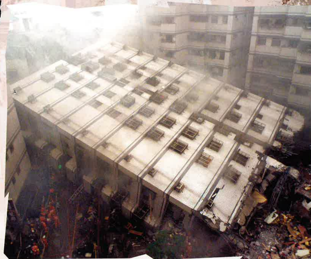
Denne boligblok væltede helt om på siden efter et jordskælv i byen Taipei på øen Taiwan.
