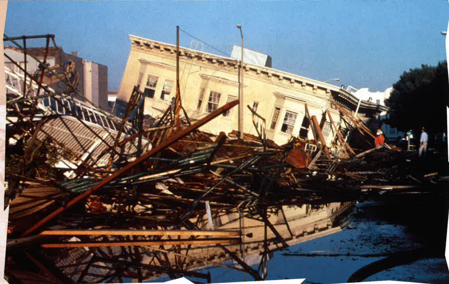
Beskadigede huse i Marina-distriktet i San Francisco Bay. Bygninger styrtede sammen, brød i brand eller sank ned i den mudrede jord.
