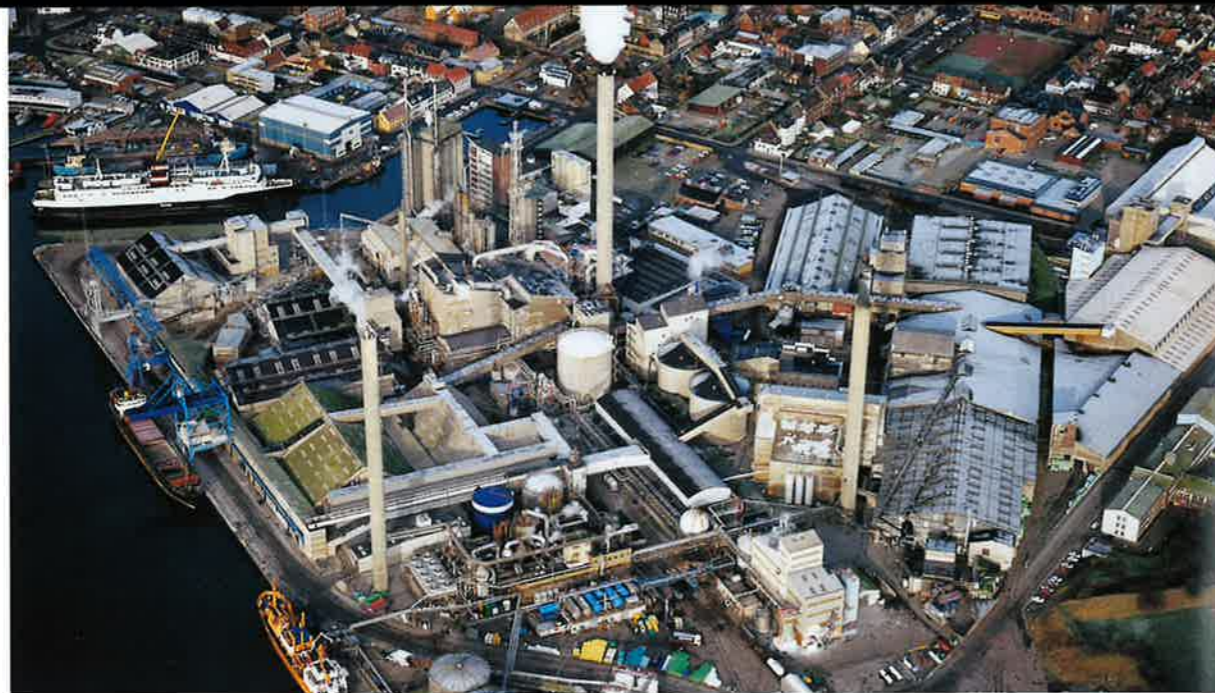
Kemiras gødningsfabrik blev bygget i Fredericia, fordi Fredericia er et knudepunkt for både jernbane- og landevejstrafik, og fordi der er en dyb og isfri havn lige ved siden af. Det har stor betydning, da der kommer kolossale mængder råvarer (ca. 1 million ton om året) til fabrikken med skib, og der ligeledes afsendes store mængder færdig gødning med skib.
