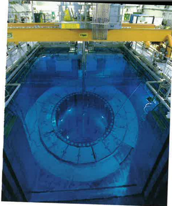
Her kan man se direkte ned i en kernereaktor. Låget er fjernet, og en kran er ved at udskifte en af uranstavene. Læg mærke til vandets flotte blå farve, som skyldes strålingen i reaktoren.
